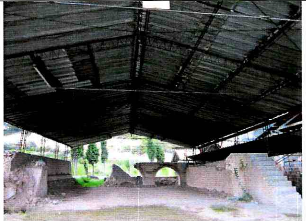
Foto 2. Vista general del interior de la edificación.
