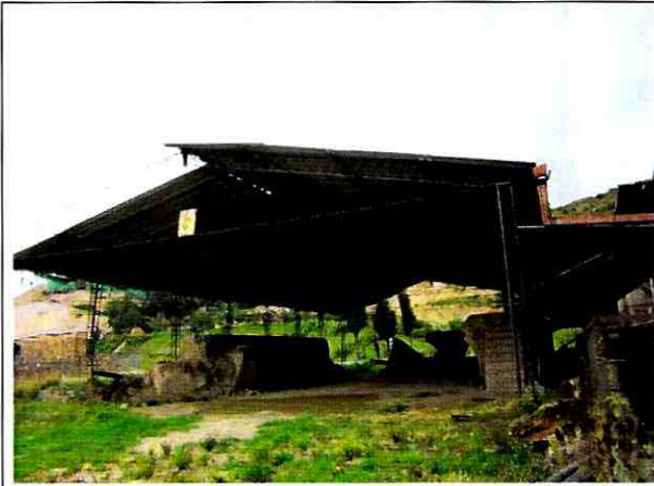
Foto 1. Aspecto externo de la edificación del concepto.
