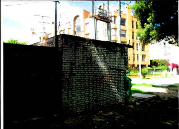
Foto 12. Deformación del piso alrededor .
