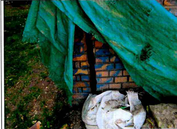
Foto 7. Fractura en el vértice noroccidental.
