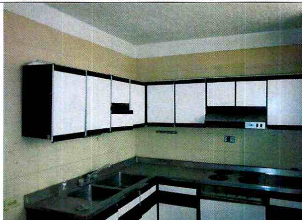
Foto 10. Acabados de muros internos sin deterioro.
