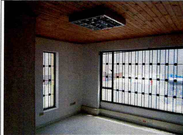
Foto 13. Muros de segundo piso en venas condiciones.
