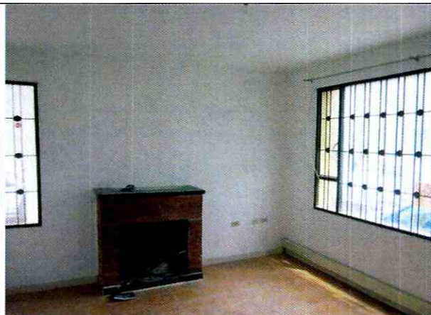
Foto 8. Internamente no se detectan daños en los muros.
