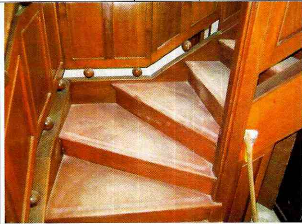
Foto 21. Escaleras sin daño estructural visible.
