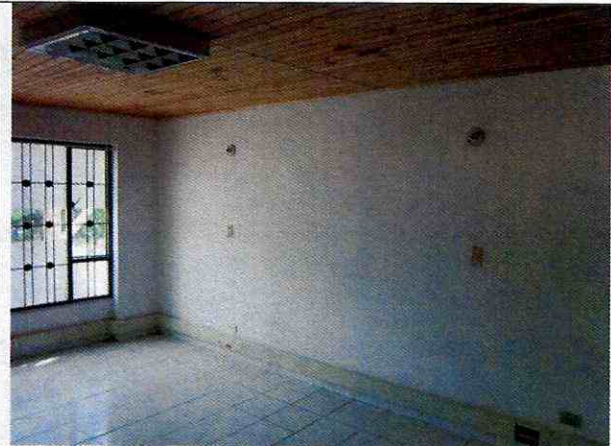
Foto 14. No se detecta daño en los muros de segundo nivel.
