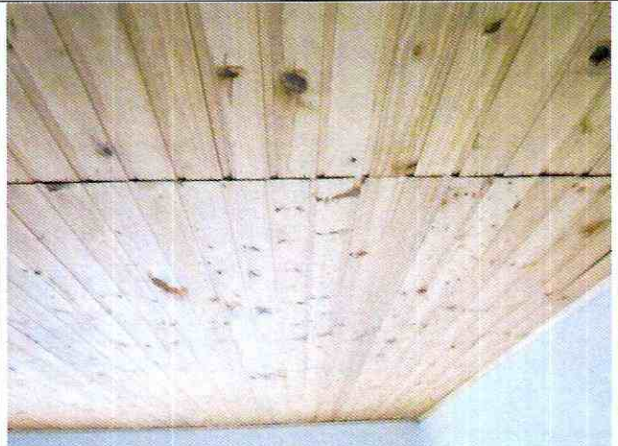
Foto 22. Cielo raso sin evidencias de daño ni deterioro.
