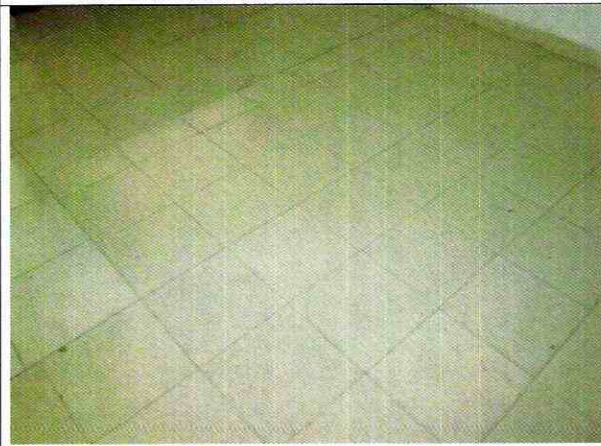
Foto 23. Placa de contrapiso sin afectaciones.
