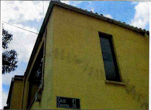
Foto 2. Reparaciones del muro de fachada.
