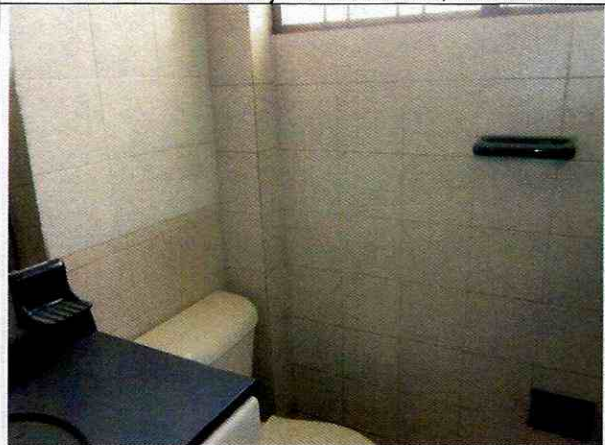
Foto 17. Acabados de muros de segundo piso sin deterioro.
