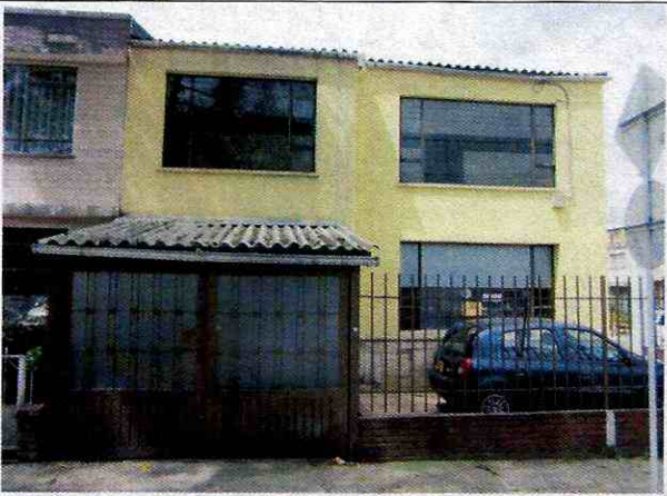
Foto 5. Fachada sobre la Carrera 26 en buen estado.
