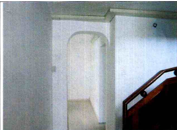
Foto 7. Muros internos de primer piso en buen estado.
