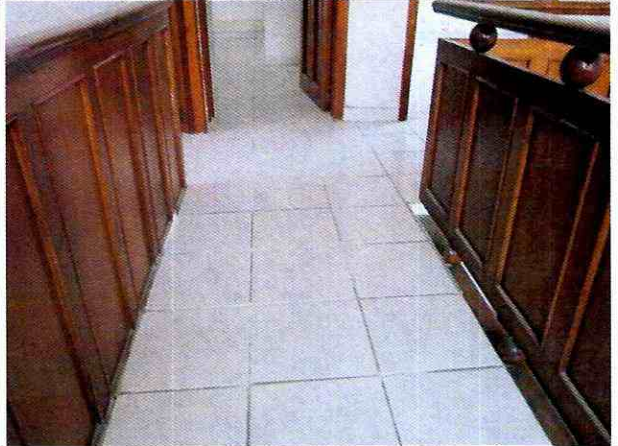
Foto 20. Acabados del entrapiso en buen estado, sin daño.
