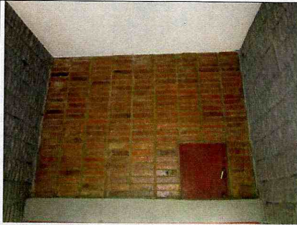
Foto 13. Muros de último piso en buen estado, daño leve.
