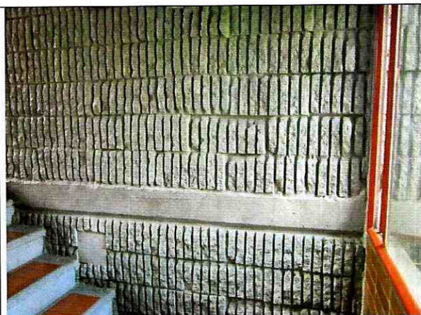
Foto 8. Muros estructurales en buen estado.
