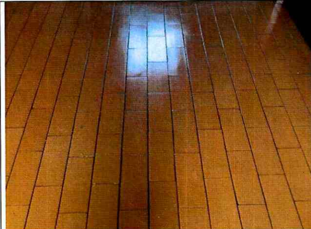
Foto 19. Placas de entrepiso sin daño estructural visible.
