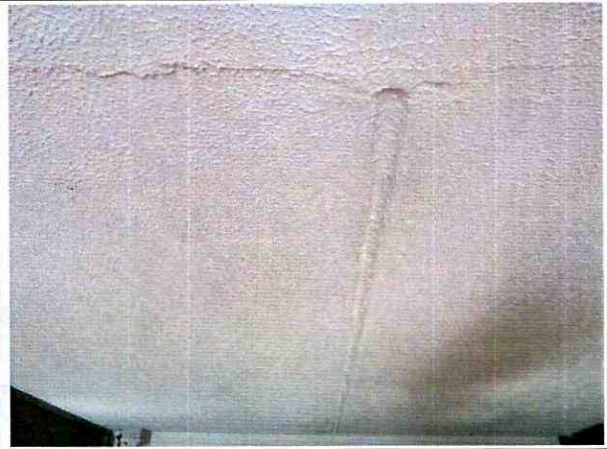
Foto 20. Placa de entrepiso en buen estado.
