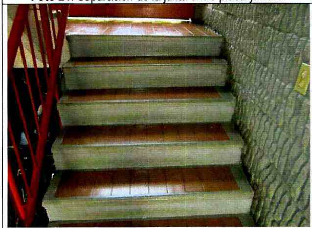
Foto 23. Escaleras en buen estado estructural.
