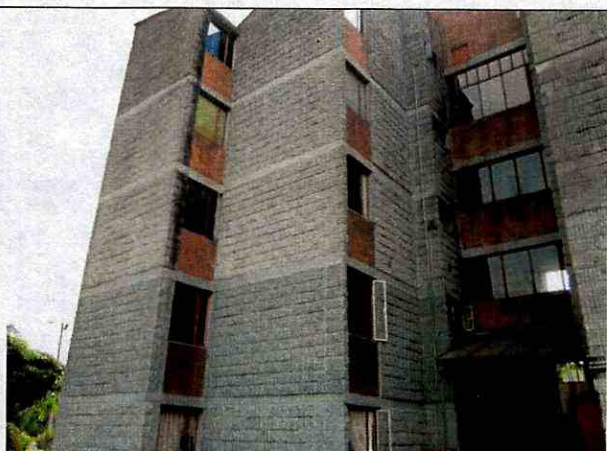
Foto 2. Fachada posterior de la edificación, sin daño visible.
