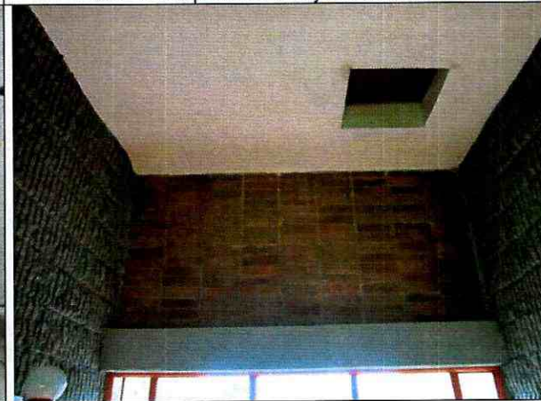
Foto 12. Muros sin evidencias de daño estructural.
