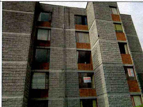
Foto 3. Muros externos sin evidencia de daño estructural.
