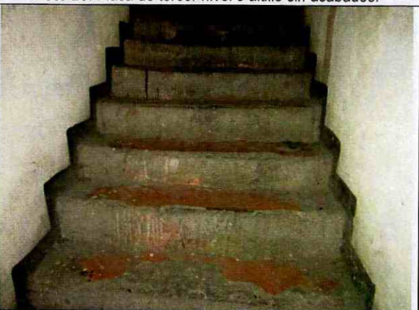
Foto 30. Escaleras a tercer nivel o altílo, sin daño estructural.
