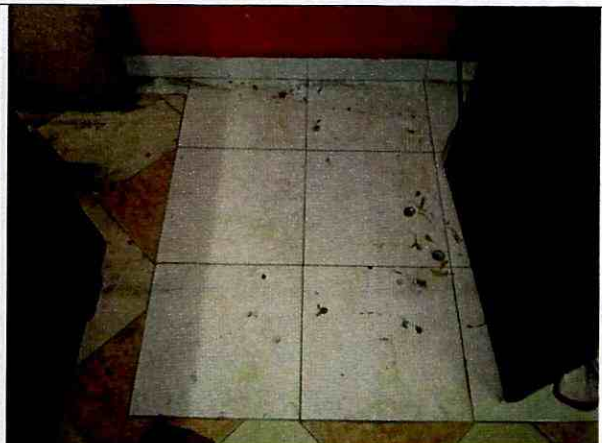
Foto 38. No se detectan daños en la placa de contrapiso.
