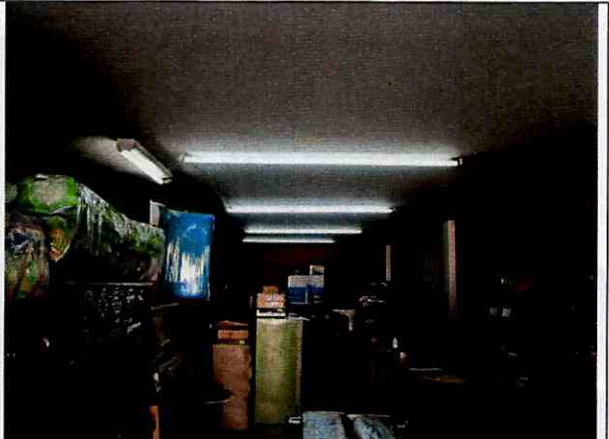
Foto 2. Vista general del interior del primer piso.
