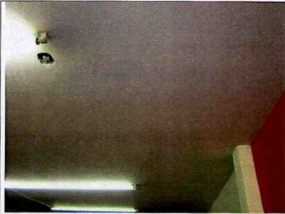
Foto 25. Cara inferior del entrepiso de segundo piso.
