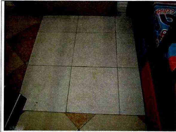
Foto 37. Acabados de la placa de piso en buen estado.
