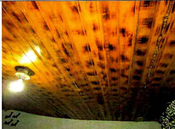
Foto 36. Cielo raso bajo cubierta en buen estado.
