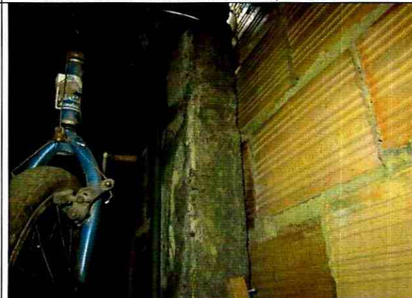
Foto 24. Columna en altillo, sin daño estructural.
