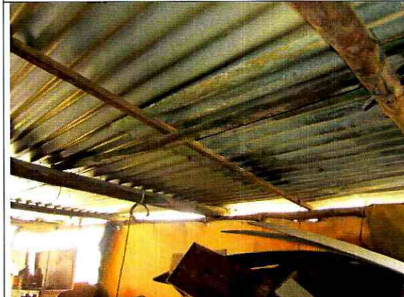
Foto 33. Cubierta liviana en tejas metálicas.
