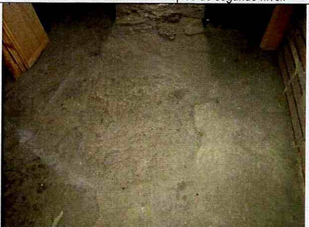
Foto 28. Placa de tercer nivel o altílo sin acabados.
