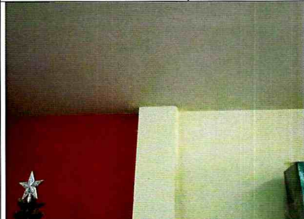
Foto 10. Columna en buen estado estructural.
