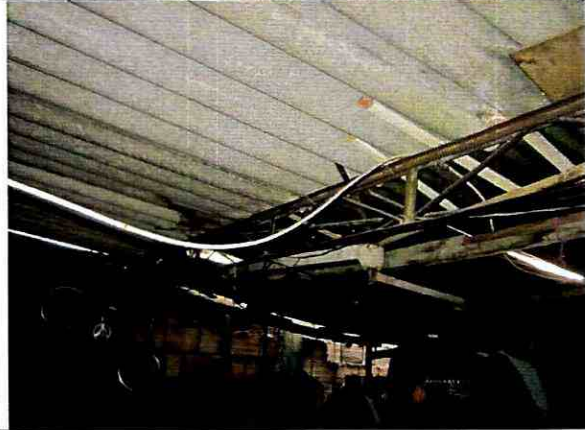
Foto 32. Cubierta liviana en tejas de fibro cemento.
