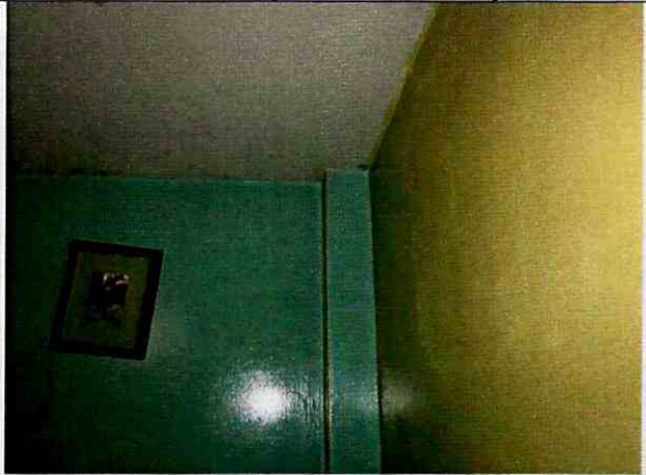
Foto 17. Columnas de segundo nivel sin daño evidente.
