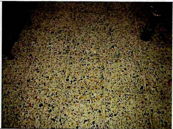
Foto 26. Buen estado del entrepiso de segundo nivel.
