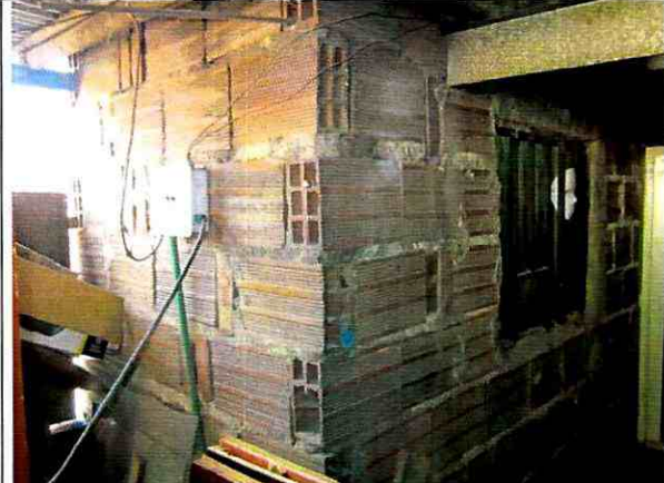
Foto 20. Muro de tercer nivel sin daño visible.
