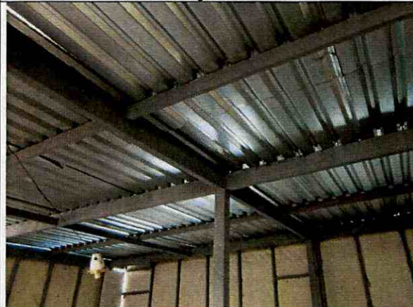
Foto 27. Cubierta y estructura sin evidencias de daños.
