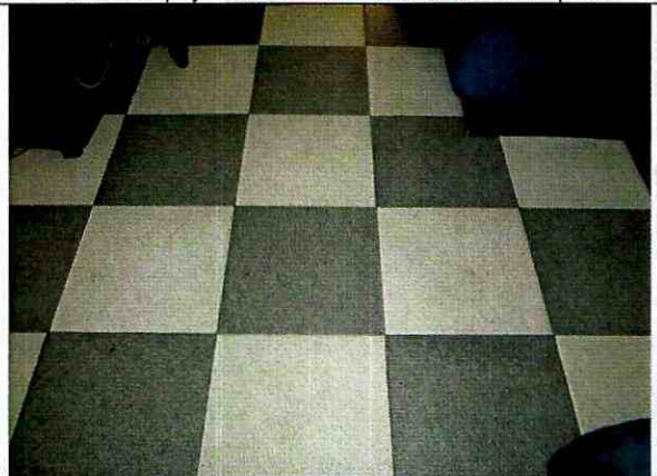
Foto 21. Acabados en buen estado, entrepiso segundo piso.
