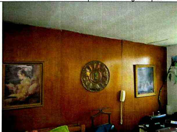
Foto 11. Muros de segundo nivel, enchape de madera.
