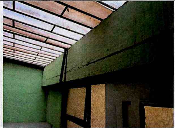
Foto 26. Viga canal y cubierta en buen estado.
