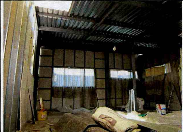
Foto 14. Aspecto general del tercer piso, muros livianos.
