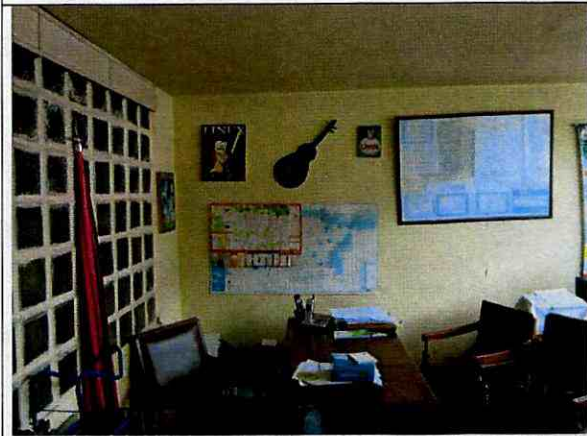
Foto 3. Muros de primer piso, buen estado estructural.
