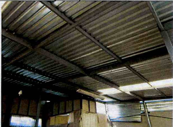
Foto 28. Buen estado de los elementos de cubierta.
