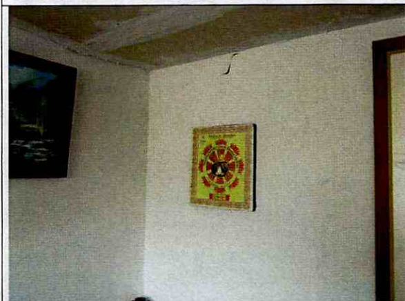
Foto 5. Muros de segundo nivel, sin daño visible.
