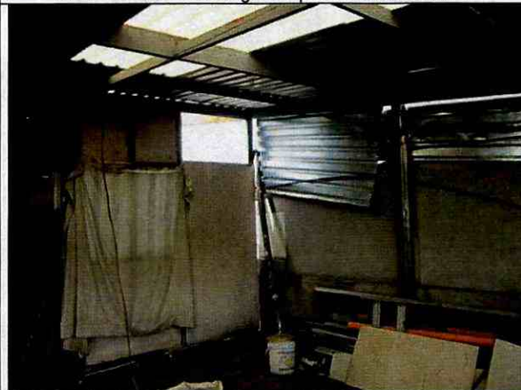
Foto 15. Muros con sola la lámina externa, sin acabados.
