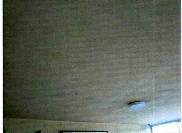
Foto 20. Cara inferior de entrepiso de segundo nivel.
