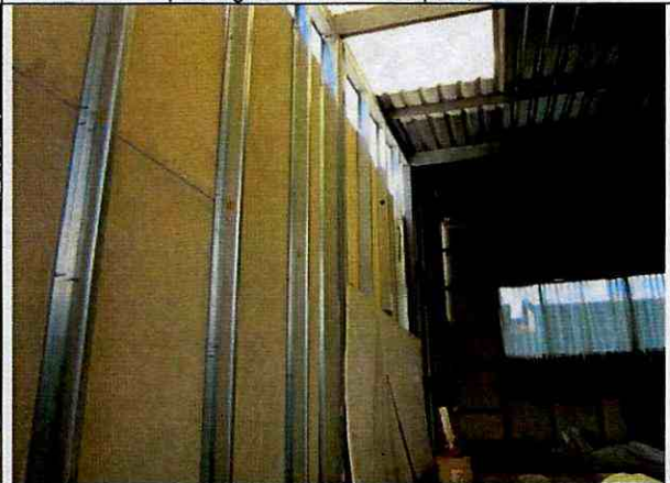
Foto 16. Muros en buen estado, solo una lámina.
