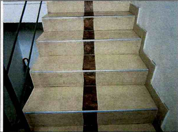
Foto 25. Escaleras a segundo nivel en buen estado.
