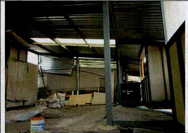
Foto 18. Estructura metálica de cubierta, buen estado.
