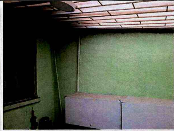
Foto 13. Muros de segundo piso en buen estado.
