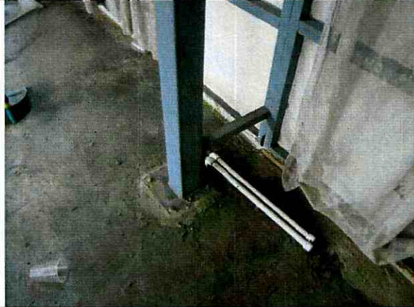
Foto 19. Apoyo de columna metálica en el entrepiso.
