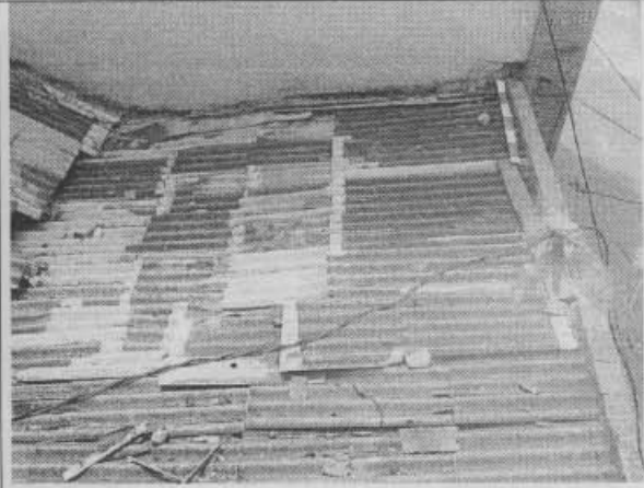
Foto 6. Cubierta sobre el costado sur del inmueble.
