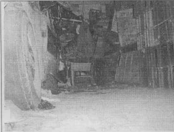
Foto 5. Vista interior del primer piso usada como almacenaje.
