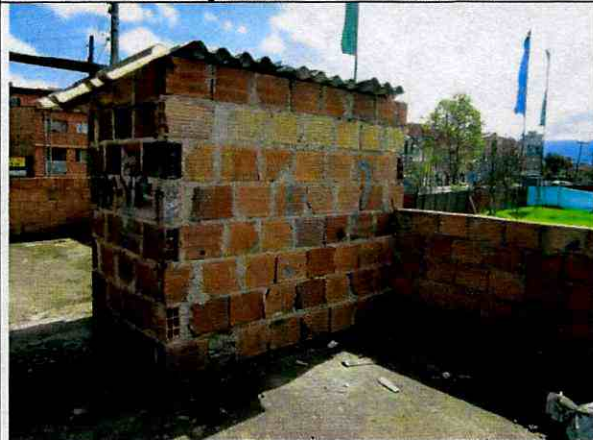
Foto 17. Muros del nivel de cubierta, sin acabados.
