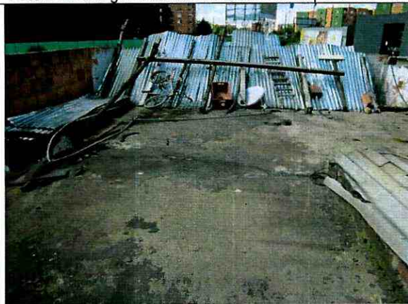
Foto 23. Aspecto de la placa de cubierta.
