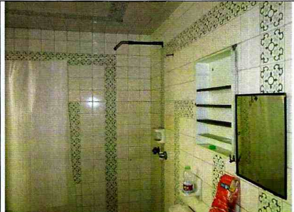
Foto 8. Muros y acabados en buen estado.
