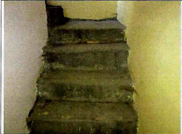
Foto 25. Escaleras en buen estado, daño leve.
