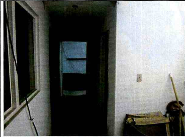
Foto 7. Aspecto general del pasillo interno.
