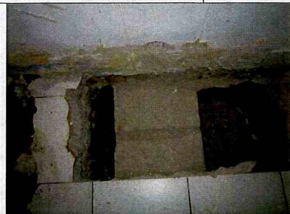
Foto 35. Excavaciones para exploración de la cimentación.
