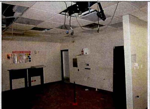
Foto 14. Muros internos del sector oriental.
