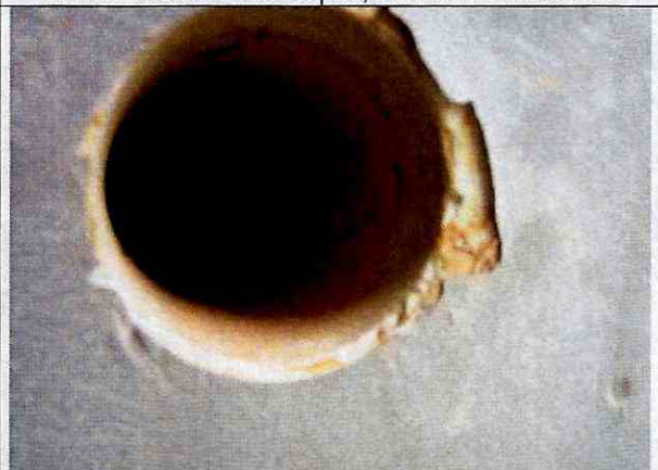
Foto 36. Perforación para toma de núcleos de concreto.
