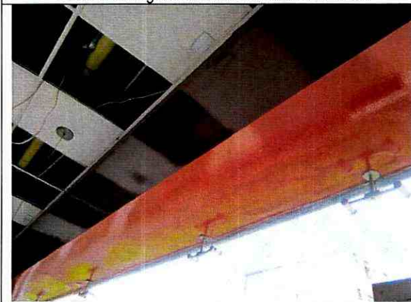
Foto 7. Viga en buen estado, retiro parcial de cielo raso.
