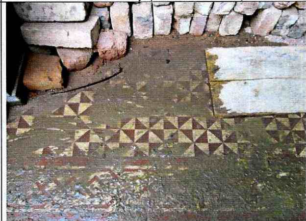
Foto 42. Placa de piso daño leve a moderado.
