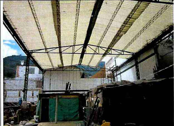
Foto 40. Cubierta en teja plástica del sector posterior.
