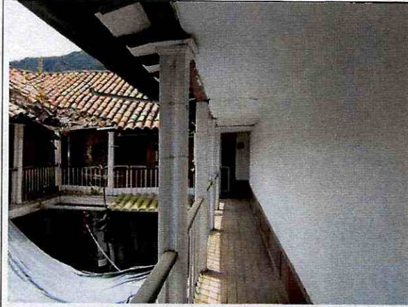
Foto 21. Estructura de madera de soporte de la cubierta.
