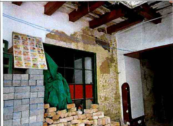
Foto 6. Muros de primer piso sector medio.
