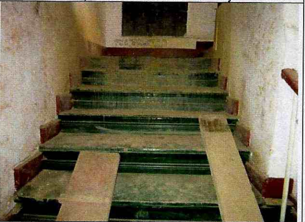
Foto 26. Escaleras de madera en buenas condiciones.
