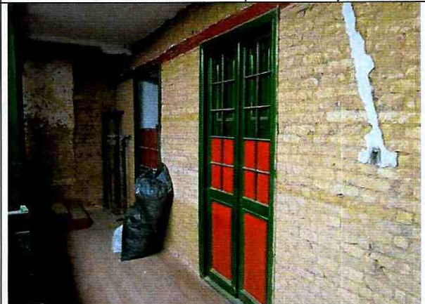
Foto 20. Retiro del pañete de muros de segundo nivel.
