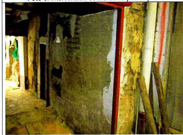
Foto 7. Retiro del revoque o pañete de los muros.
