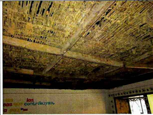
Foto 39. Cielo raso bajo entepiso parcialmente retirado.
