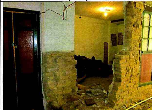
Foto 8. Demolición parcial de muro de primer piso.
