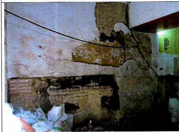
Foto 5. Intervención de muros de primer piso.
