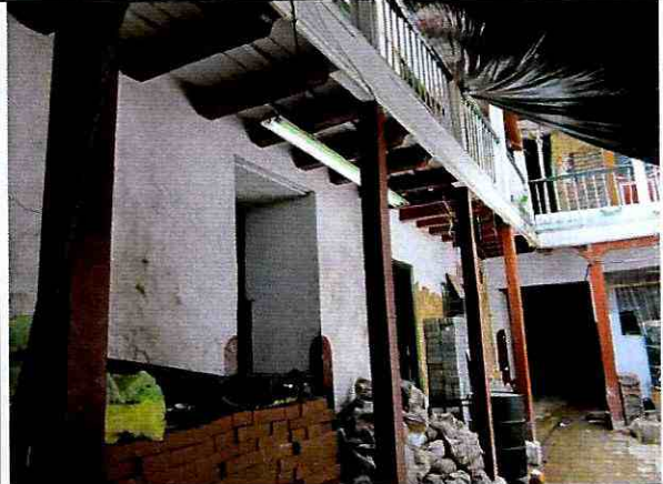
Foto 4. Aspecto del interior de la edificación.
