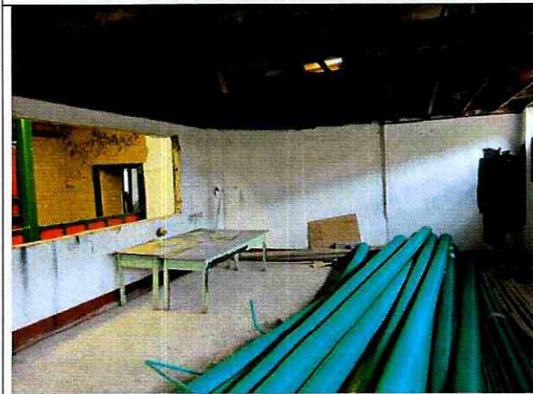
Foto 19. Muros de segundo piso con poco deterioro.
