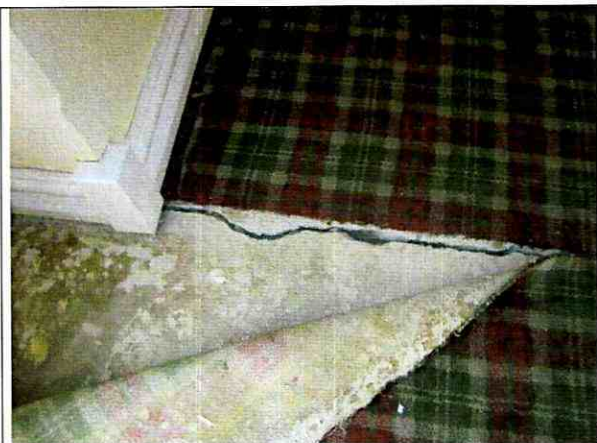
Foto 29. Separación de la junta entre placas de entripiso.
