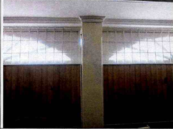
Foto 11. Columna en buenas condiciones.
