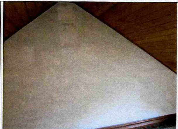
Foto 24. Muro sin evidencia de daño en el altillo.
