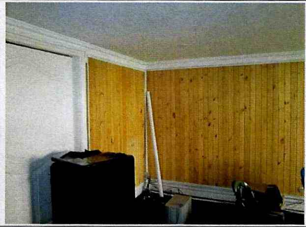
Foto 12. Muros internos sin evidencias de daños.
