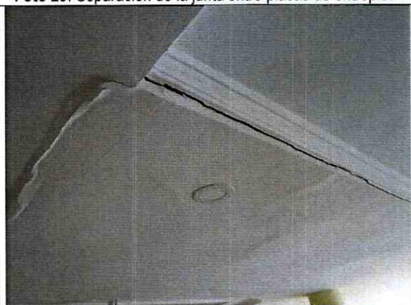
Foto 31. Separación de las láminas del cielo raso.
