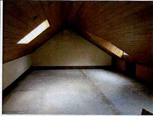
Foto 23. Vista general del altillo.
