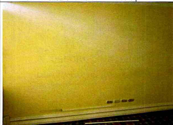
Foto 20. Muros de segundo piso en buen estado.
