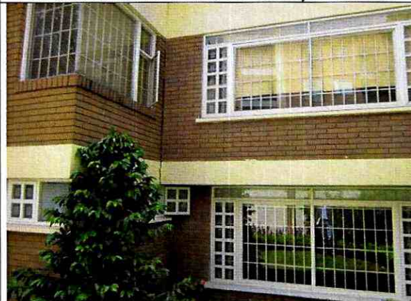
Foto 7. Fachada interna en el sector del patio.
