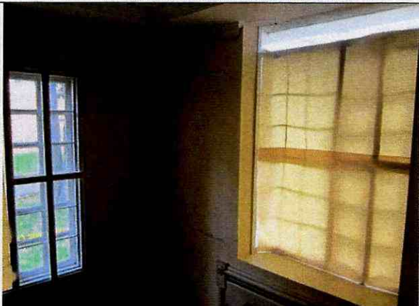
Foto 14. Grietas y fractura de muros internos, daño severo.
