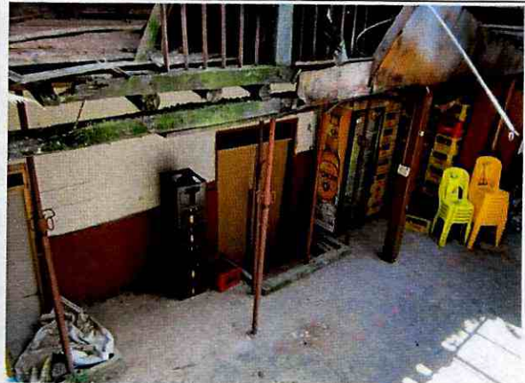
Foto 26. Apuntalamiento provisional del entrespiso.
