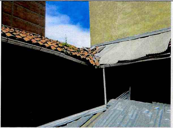
Foto 39. Reemplaza de las tejas de barro por lámina.
