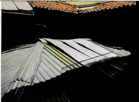
Foto 38. Cubierta en lámina metálica.
