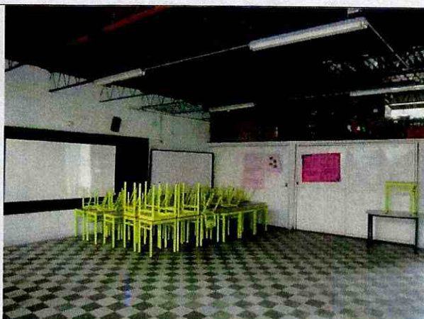
Foto 8. Vista interior de las aulas, sin daño evidente.
