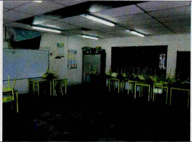
Foto 20. Muros del extremo sur sin evidencia de daño.
