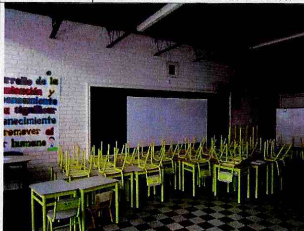
Foto 9. Muros internos en buenas condiciones.
