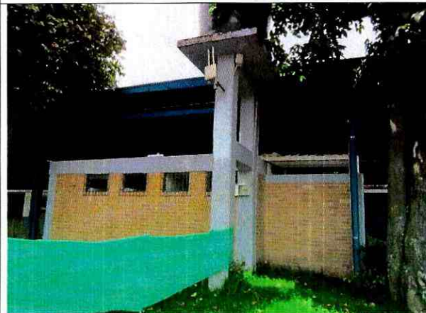
Foto 5. Batería de baños y estructura de tanques.
