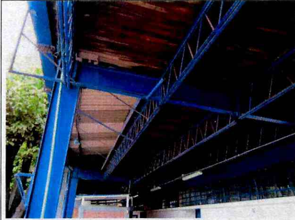
Foto 21. Columnas y vigas del alero frontal en buen estado.
