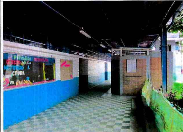
Foto 6. Hall y alero del sector frontal, sin daños visibles.
