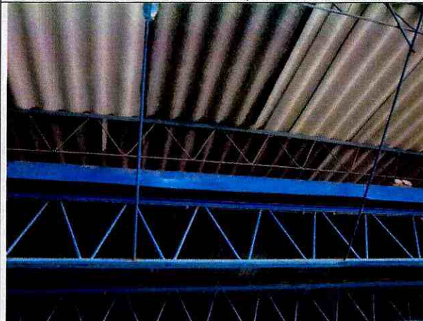
Foto 33. Elementos metálicos de cubierta sin daños.
