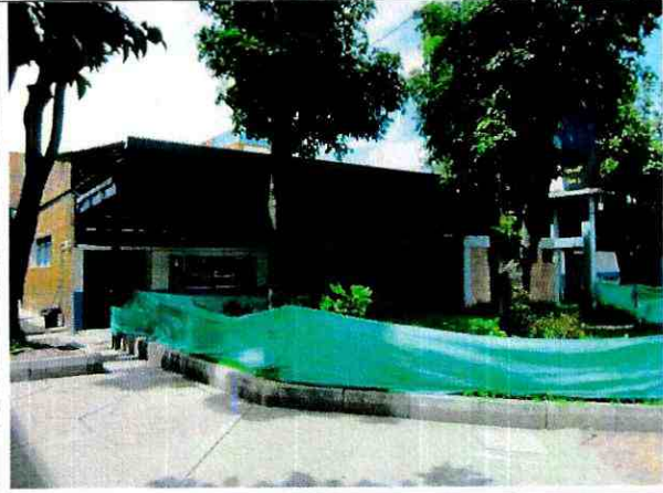
Foto 1. Vista externa del edificio objeto del concepto.
