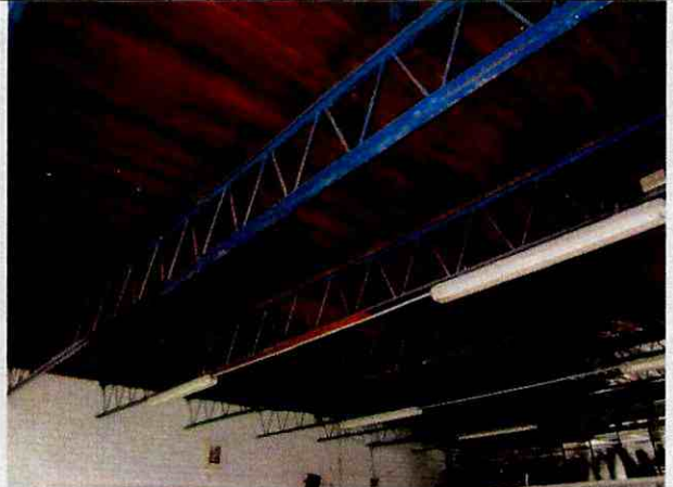
Foto 22. Cielo raso y elementos metálicos sin daño.
