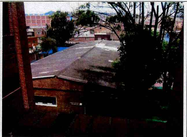
Foto 34. Cubierta de la edificación.
