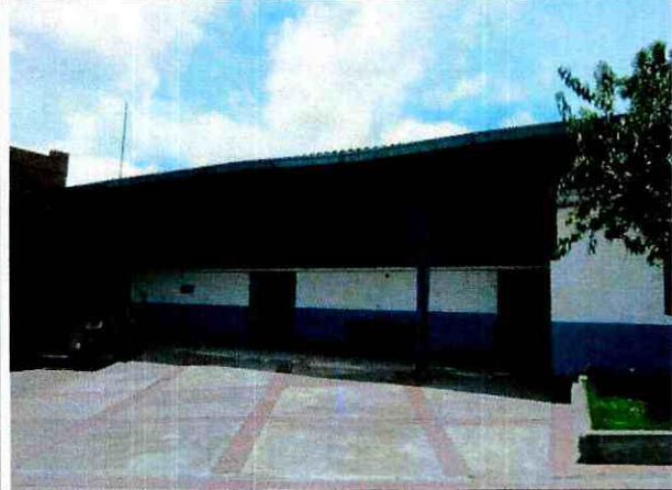
Foto 2. Muros y elementos externos en buenas condiciones.
