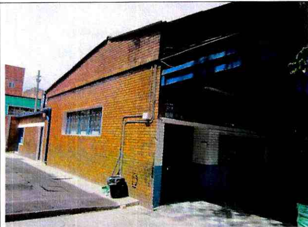
Foto 3. No se detectan daños en los elementos externos.
