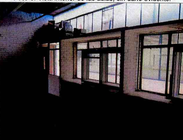
Foto 10. Muros y elementos internos sin evidencia de daño.
