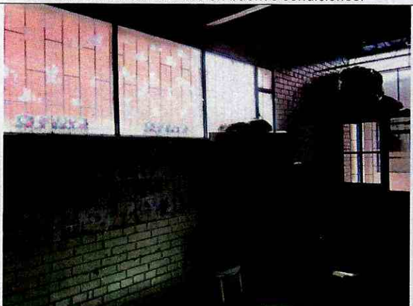
Foto 11. Muros y sus acabados en buen estado.
