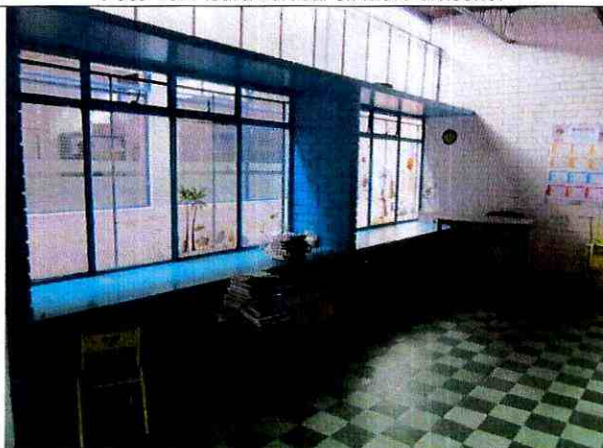
Foto 17. Muros del sector de la ventana.
