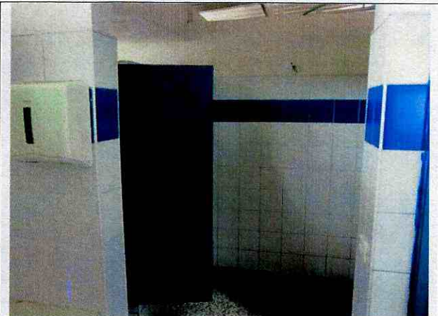
Foto 32. Muros internos de los baños en buen estado.
