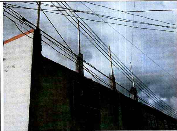
Foto 11. Columnetas de concreto a nivel de cubierta.
