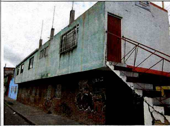
Foto 3. Aspecto de la fachada del costado occidental.
