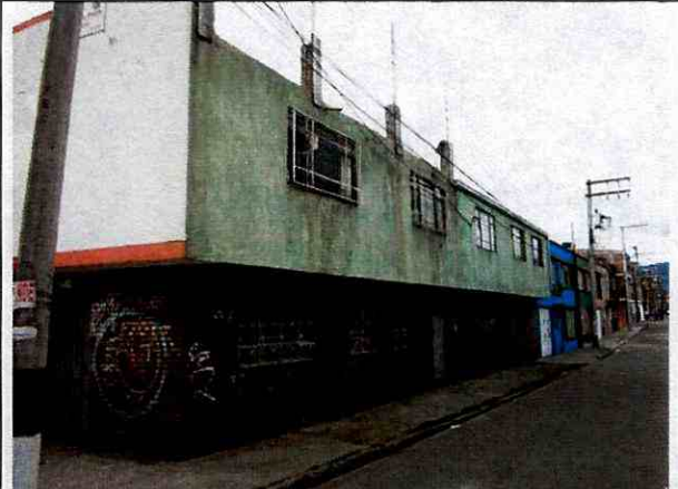
Foto 2. Fachada del costado oriental.
