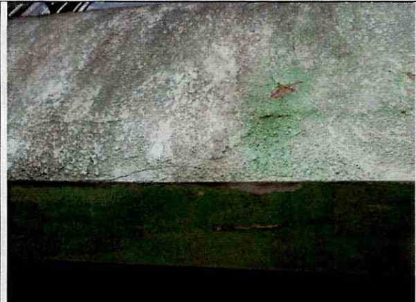
Foto 14. Fisuras en la placa de entrepiso.
