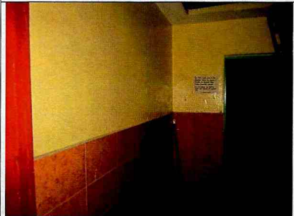
Foto 3. Muros internos en buenas condiciones.
