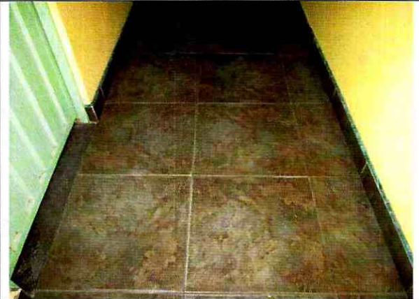
Foto 10. Entepiso de segundo nivel en buenas condiciones.
