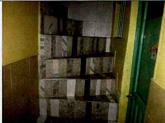
Foto 15. Escalera en concreto sin evidencia de daños.
