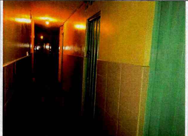
Foto 2. Aspecto general interno del primer piso, buen estado.
