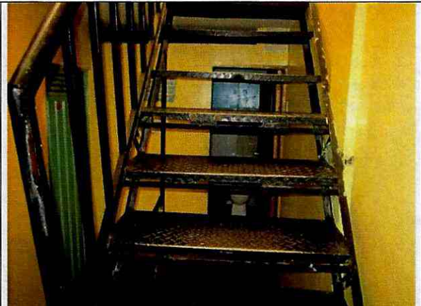
Foto 14. Escalera metálica de segundo a tercer piso.
