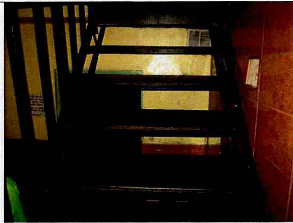
Foto 13. Escalera del sector posterior sin daños.
