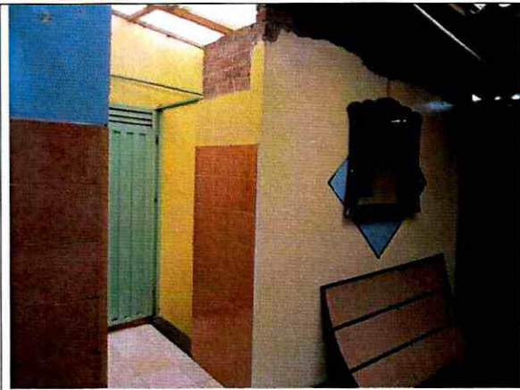
Foto 7. Muros de tercer piso en buen estado.
