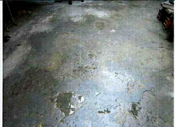
Foto 12. Placa de entepiso de tercer nivel sin daños.
