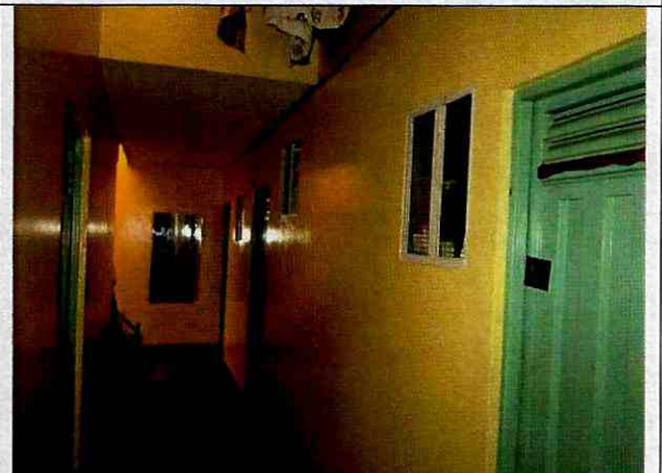
Foto 4. Muros internos del segundo piso en buen estado.
