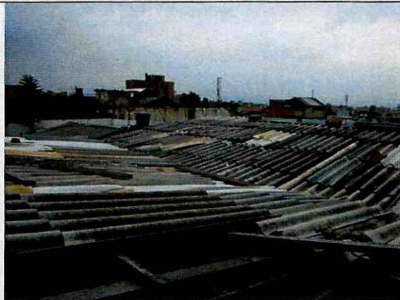
Foto 17. Cubierta en buen estado.
