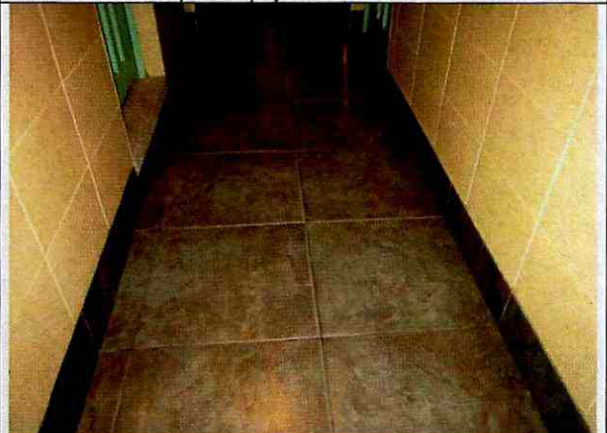
Foto 18. Placa de piso en excelentes condiciones.
