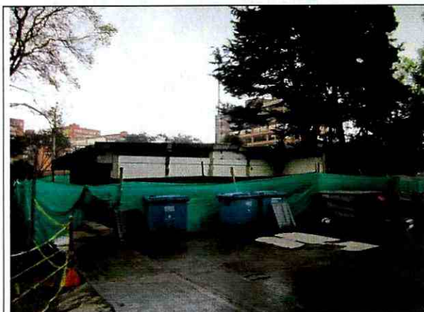
Foto 1. Vista externa de la edificación objeto del concepto.
