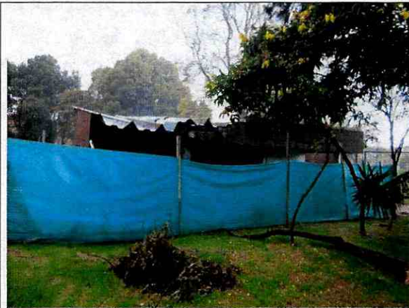
Foto 3. Muro externo del extremo norte, mal estado.
