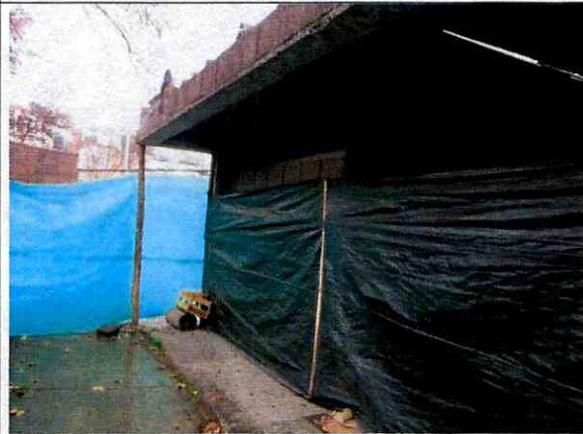
Foto 5. Apuntalamiento temporal y protección con plástico.
