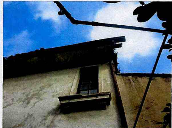
Fotos 9 y 10. Daños en molduras de la fachada y alero de la cubierta.
