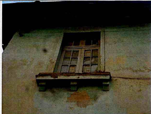
Fotos 9 y 10. Daños en molduras de la fachada y alero de la cubierta.
