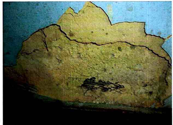
Foto 8. Los muros divisorios del segundo nivel presentan refuerzo de malla metálica.
