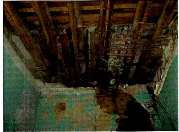
Foto 6. Entrepiso conformado por vigas en madera, hacia la parte superior machihembre y hacia la parte inferior esterilla con mortero, condición en la cual se encuentra en algunos espacios que no están en uso.
