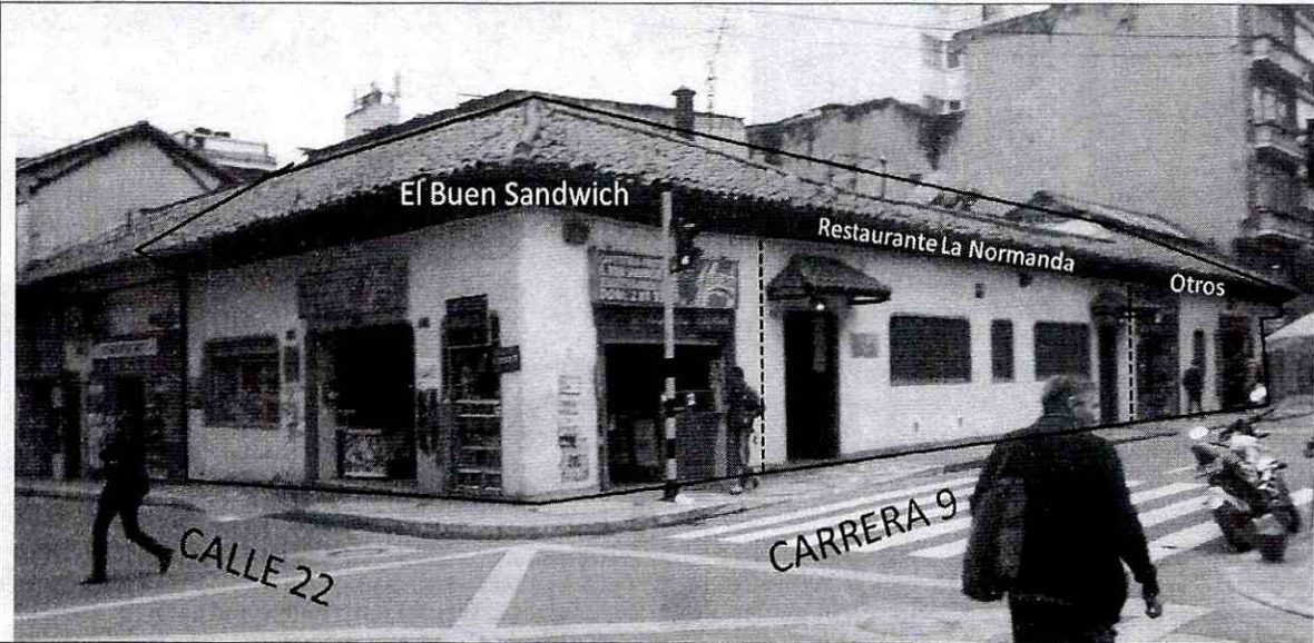
Foto 1. Vista general de la edificación identificada con el CHIP: AAA0029OLAF, en cuyo costado sur se localiza el inmueble objeto de la visita.
