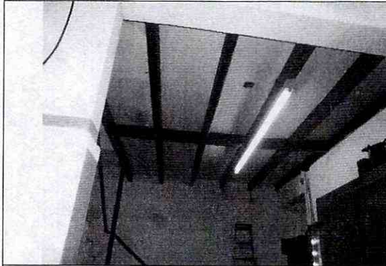
Foto 10. Vigas en madera correspondientes al entrepiso en el Restaurante La Normanda.
