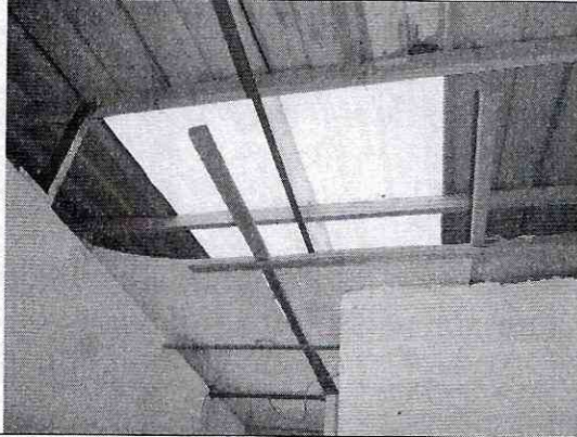
Foto 9. Cielo raso en láminas plásticas traslúcidas.
