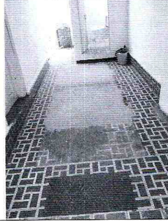
Fotos 10 y 11. Condición de la placa de entrepiso donde anteriormente se localizaban espacios para el paso de luz.
