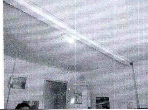
Foto 9. Perfil metálico soporte de la placa de cubierta.
