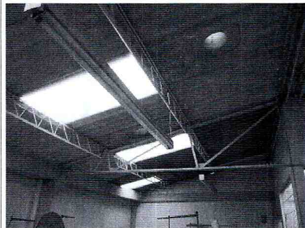
Foto 8. Aspecto general de la cubierta.
