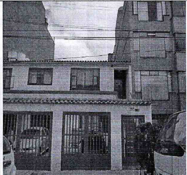
Foto 10. Fachada del predio de la Calle 135 A No. 9 A - 20.
