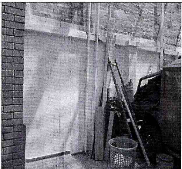
Foto 8. Muro de lindero del predio vecino.
