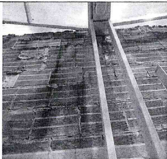
Foto 5. Muro en buenas condiciones, sin grietas ni fracturas.
