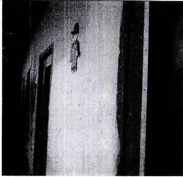
Foto 13. Muros del pasillo del segundo nivel.
