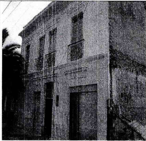
Foto 1. Vista externa del edificio objeto del concepto.
