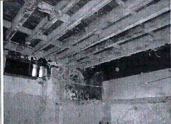
Foto 22. Aspecto inferior del entrepiso en madera.
