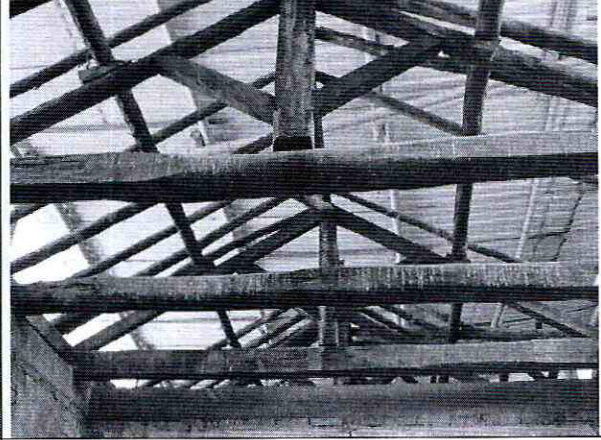
Foto 32. Estructura de madera de cubierta.
