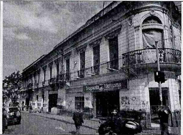
Foto 2. Fachada del inmueble sobre la calle 22.
