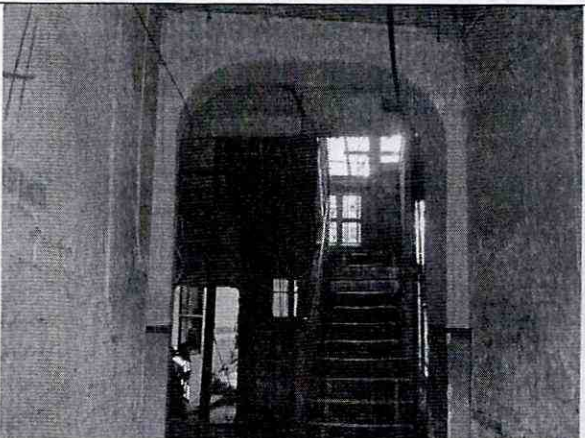
Foto 5. Muros internos de primer piso.
