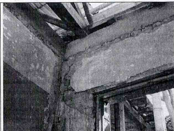
Foto 37. Construcción de viga cinta en la corona de muros.
