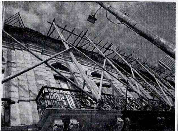
Foto 4. Fachada y elementos de apuntalamiento.
