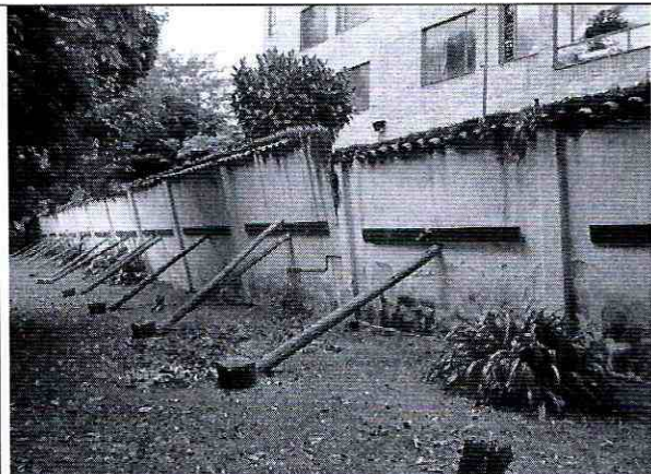
Foto 2. Muro de lindero del costado norte del predio.
