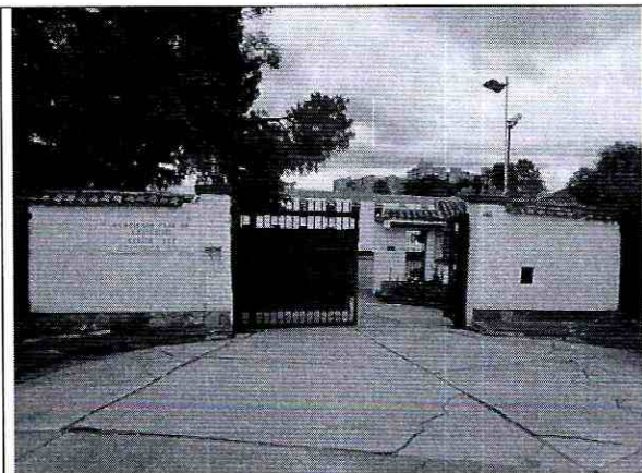
Foto 1. Fachada del predio al que pertenece el muro.
