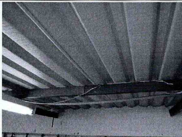
Foto 32. Cubierta en lámina metálica, sector posterior.
