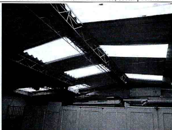
Foto 34. Cubierta del patio interno sin daño visible.
