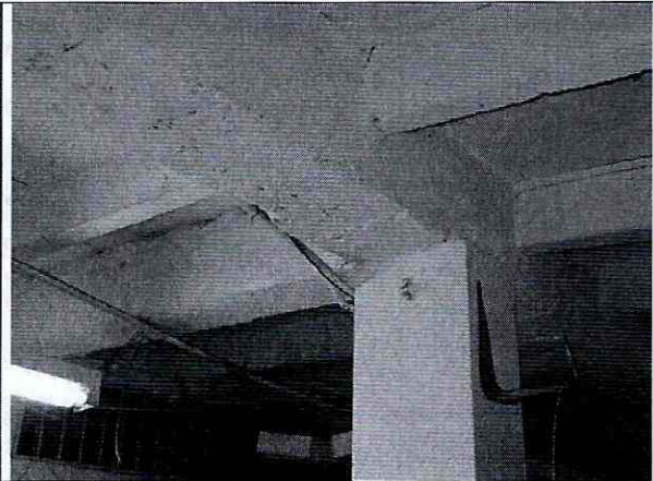
Foto 20. Elementos estructurales del entrepiso.
