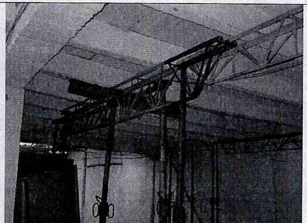
Foto 4. Primer piso, apuntalamiento del entrepiso.
