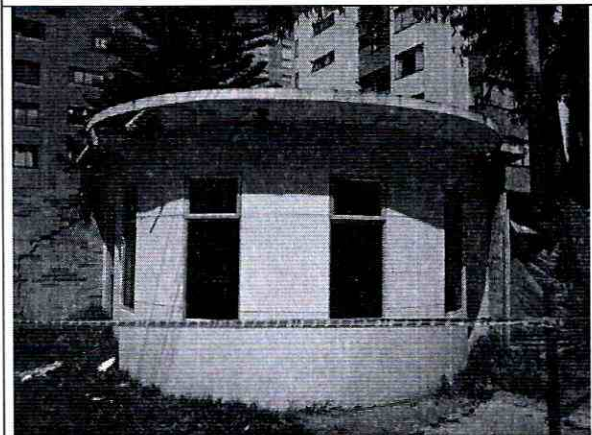
Foto 11. Edificación de un piso en muros livianos.
