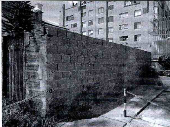
Foto 10. Muro de lindero costado norte, sin daño visible.
