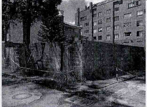
Foto 2. Muros de cerramiento costados oriental y norte.
