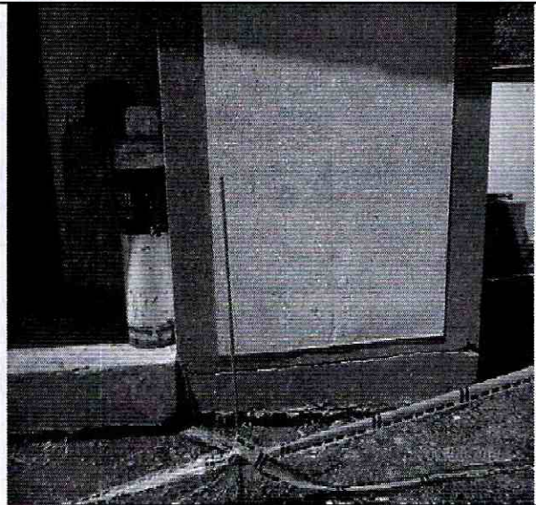
Foto 8. Elementos de la base de los muros.
