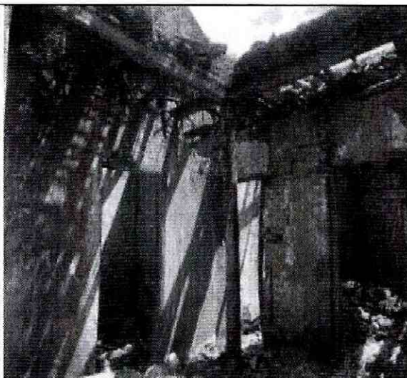
Fotos 7 y 8. Vista de los muros de carga y la cubierta de la edificación con colapsos parciales.
