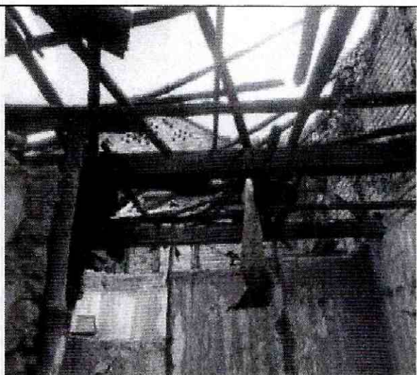
Fotos 7 y 8. Vista de los muros de carga y la cubierta de la edificación con colapsos parciales.
