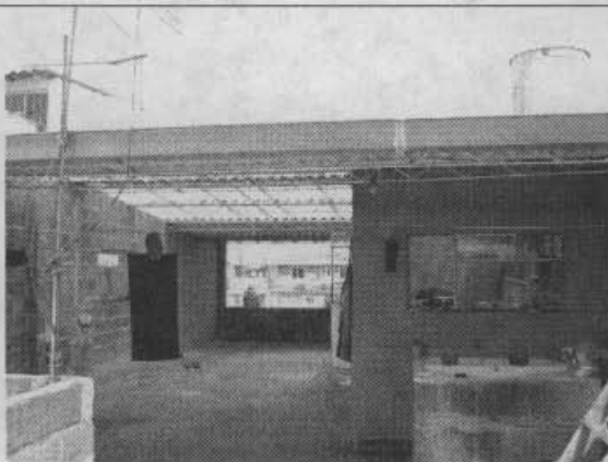
Foto 3. Estructura de cubierta de la azotea.
