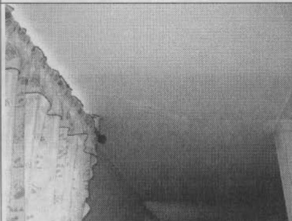
Foto 9. Placa con marcas de infiltración de agua.
