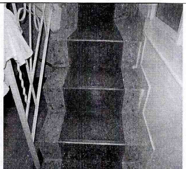
Foto 30. No se evidencia daño en las escaleras.
