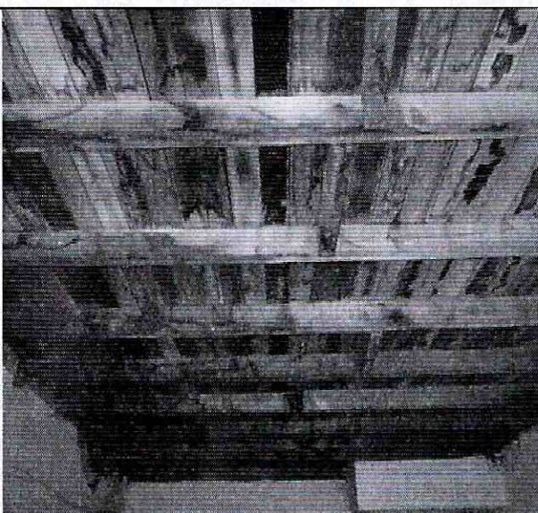
Foto 24. Entrepiso en madera en buenas condiciones.
