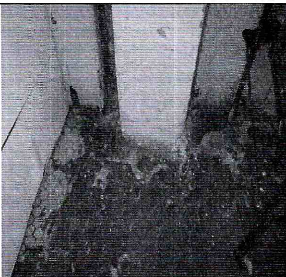
Foto 35. Buen estado del piso en el sector de la columna.
