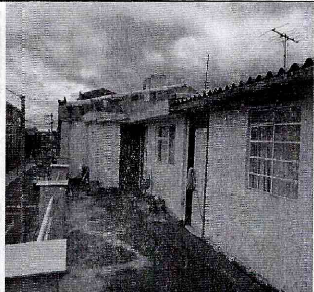
Foto 16. Aspecto general de tercer nivel o altillo.
