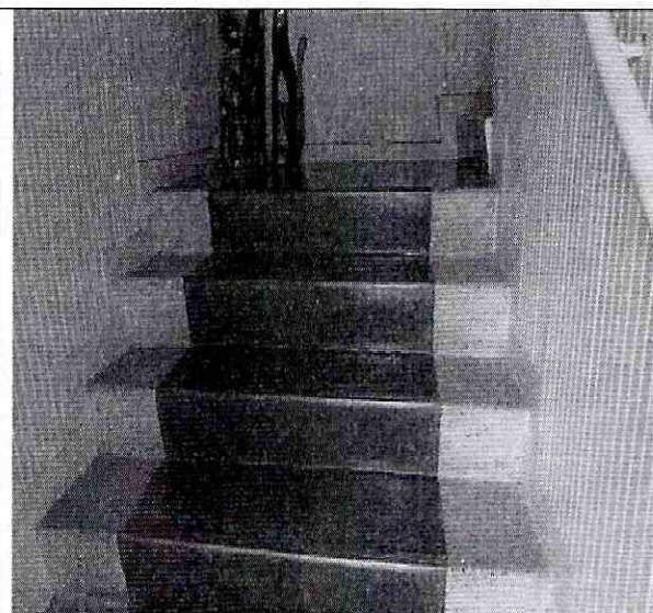
Foto 29. Escaleras en buenas condiciones.
