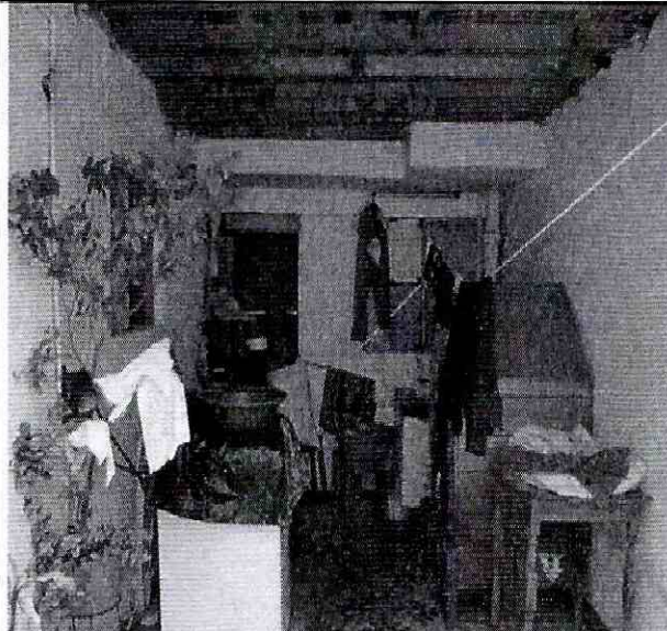
Foto 5. Elementos internos de primer piso.
