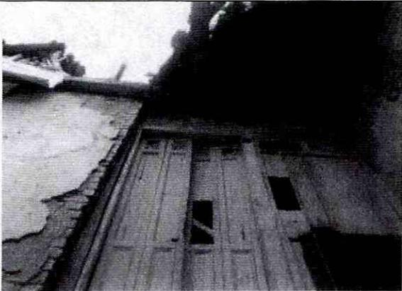
**Foto 5.** Detalle del segundo piso, se observa colapso parcial de cubierta.
