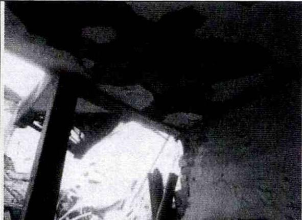
**Foto 4.** Primer piso. Detalle del cielo raso donde se observa colapso de loseta inferior.
