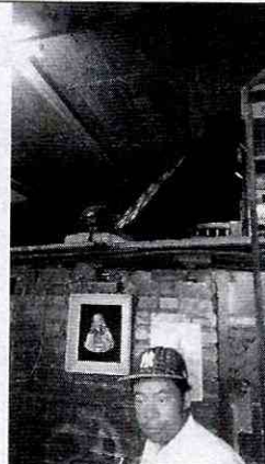
Foto 2. Placa de entpiso en buenas condiciones
