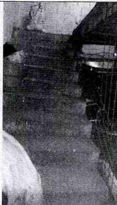
Foto 4. Escalera sin mal comportamiento estructural.
