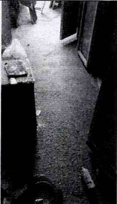
Foto 6. Entrepisos sin afectaciones estructurales.
