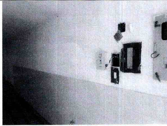
Foto 7. Muro lateral en buen estado
