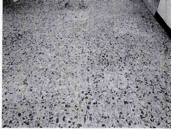
Foto 25. Entrepiso en concreto, no se detecta daño.
