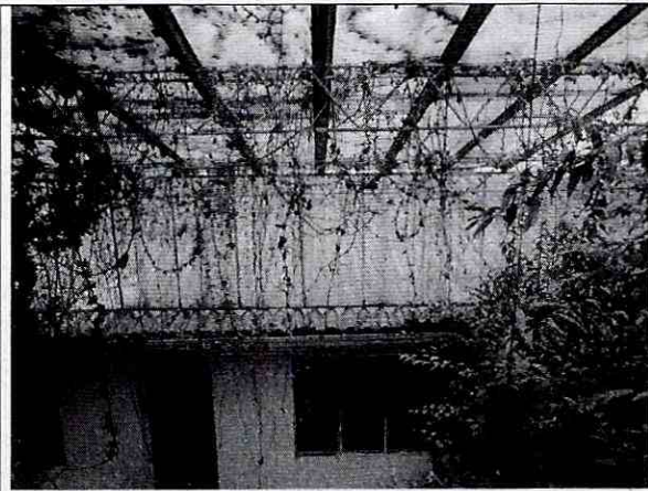
Foto 37. Cubierta de la edificación del sector posterior.
