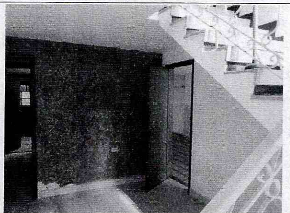
Foto 4. Interior del inmueble muros en buen estado.
