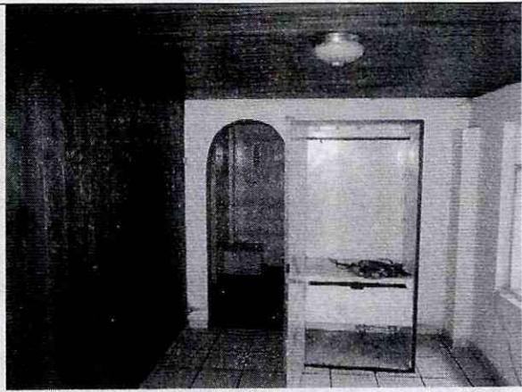
Foto 18. Muros internos en edificación posterior.
