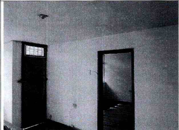
Foto 12. Elementos de segundo piso en buenas condiciones.
