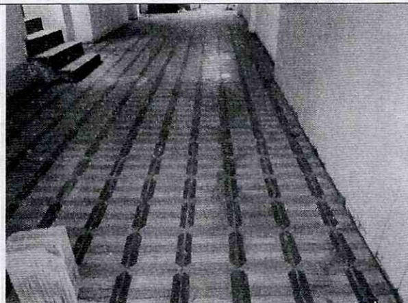
Foto 40. No se detectan daños en el piso de la edificación.
