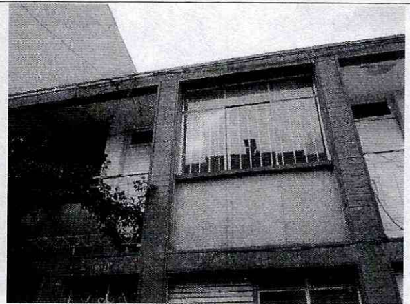
Foto 2. Muros de fachada sin evidencia de daños.
