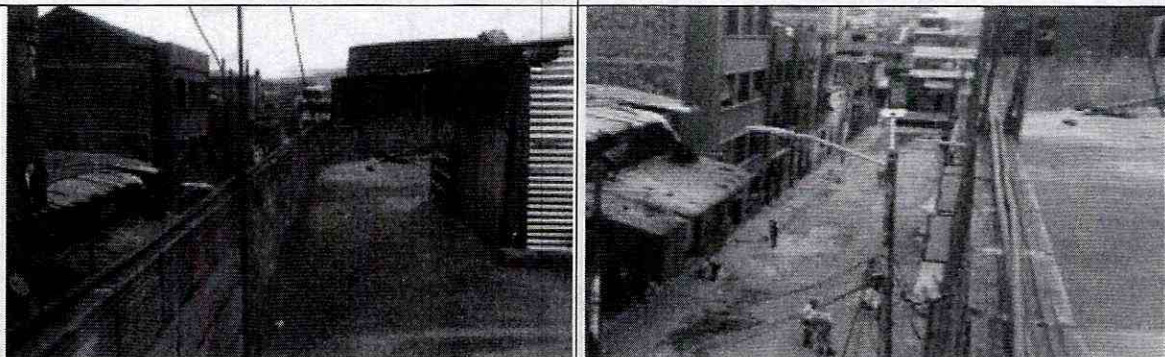
Fotos 5 y 6. Vista desde la terraza, se puede observar el sistema de mampostería confinada en los muretes.
