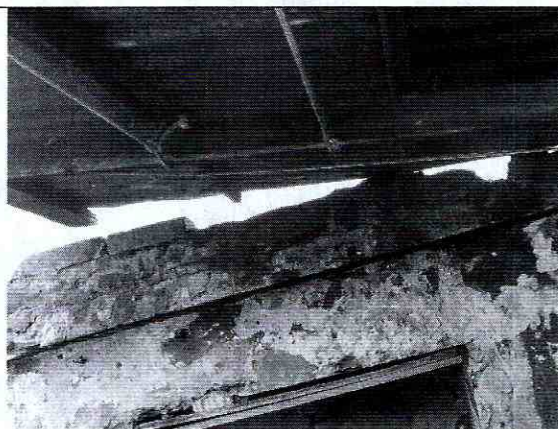
Foto 23. Elementos de cubierta en buen estado.
