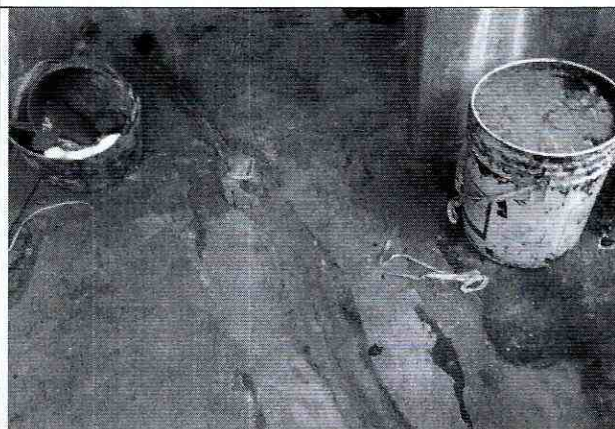
Foto 24. Placa de concreto en buenas condiciones
