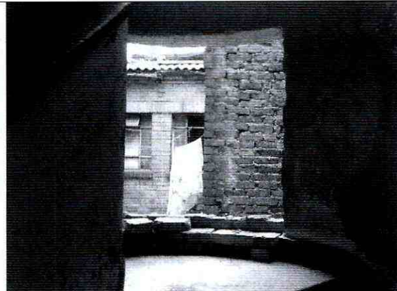
Foto 12. Escaleras de acceso al tercer nivel en buen estado
