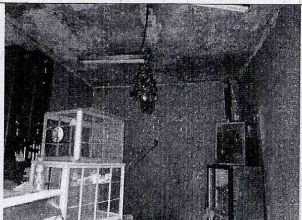
Foto 4. Muros de locales del primer piso sin daño.
