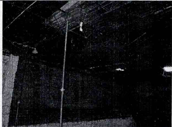
Foto 27. Cubierta del sector posterior, daño leve.
