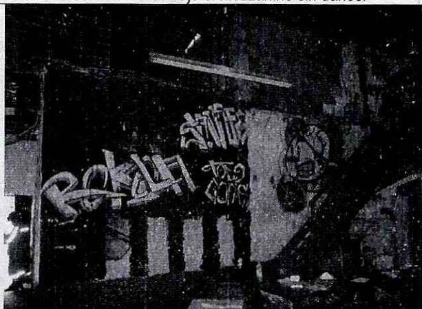
Foto 16. Deterioro de los acabados de los muros, daño leve.
