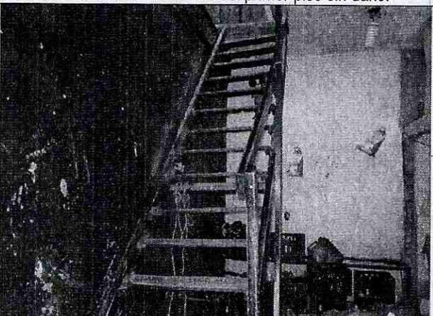
Foto 6. Muros y elementos de primer piso.
