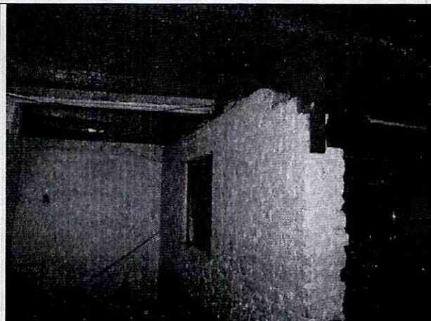
Foto 14. Muros bajo el mezzanine sin daños.
