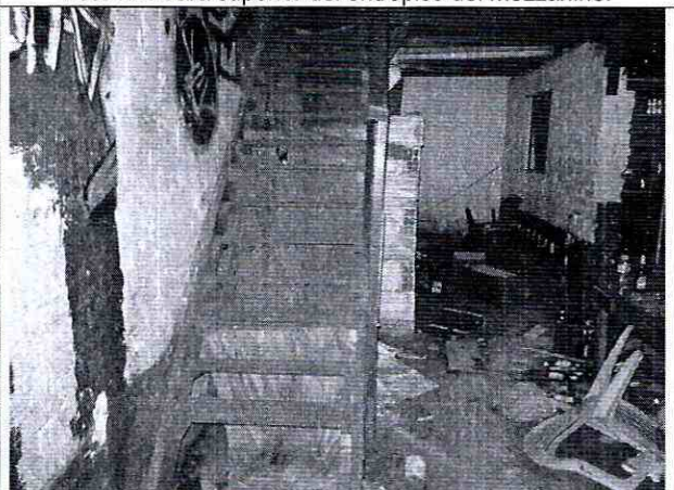
Foto 24. Escaleras en madera del sector posterior.
