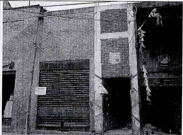
Foto 3. No se detecta daño en los muros de fachada.
