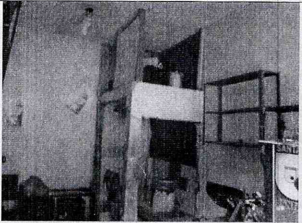
Foto 5. Muros de primer piso sin afectaciones.
