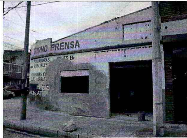
Foto 20. Fachada sobre la Calle 2 Sur.
