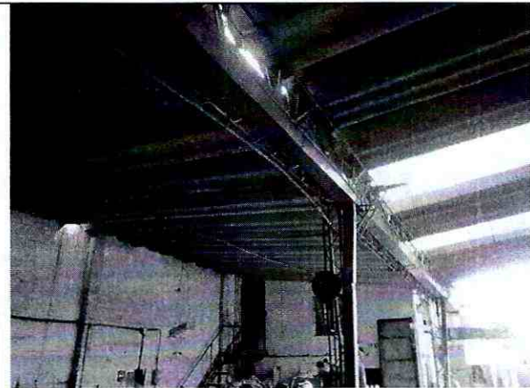
Foto 21. Cubierta en buen estado, daño leve y deterioro.
