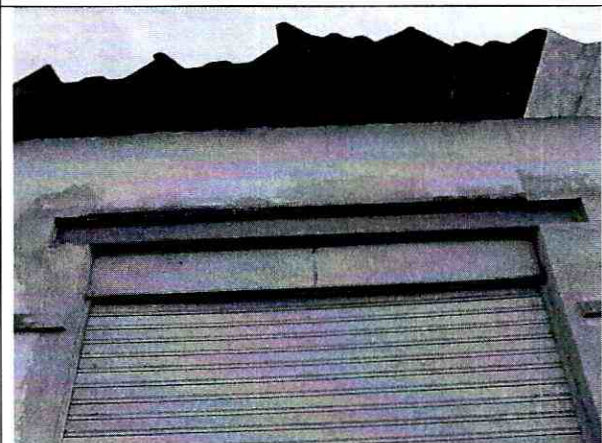
Foto 9. Viga metálica para soportar portón.
