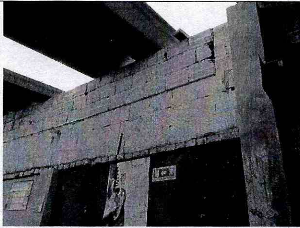
Foto 13. El muro es elemento de soporte de la cubierta.
