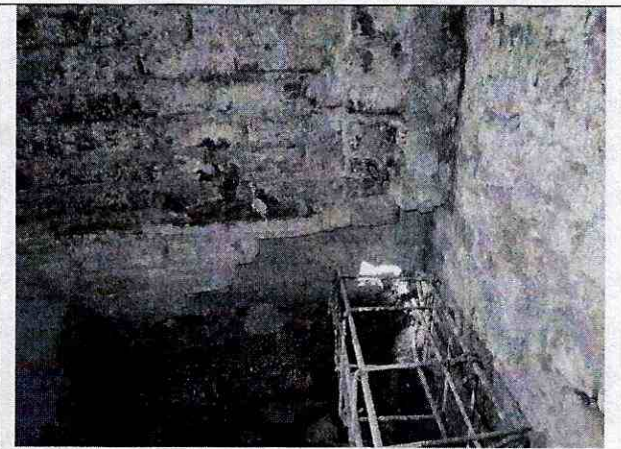
Foto 16. Intervención en la cimentación.
