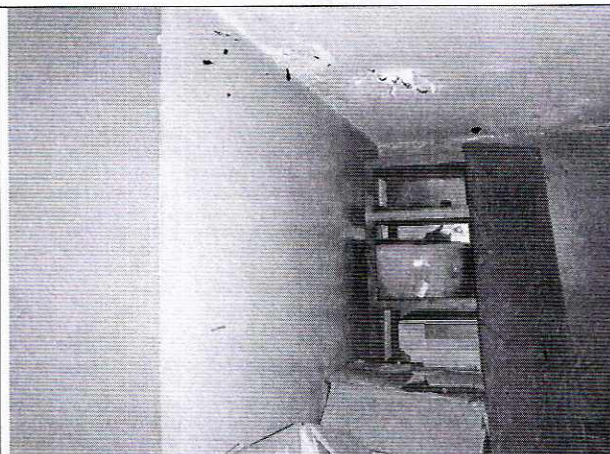
Fotos 13 y 14. Vista interior segundo piso parte central. Humedades y eflorescencias bajo placa
