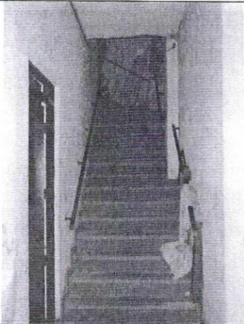
Foto 9. Escalera primer piso. No se observa daños
