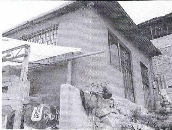
Foto 3. Vista exterior inmueble costado suroccidental del predio. No se observa daños
