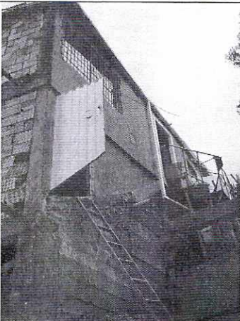
Foto 7. Vista lateral ingreso al sótano. No se observa daños
