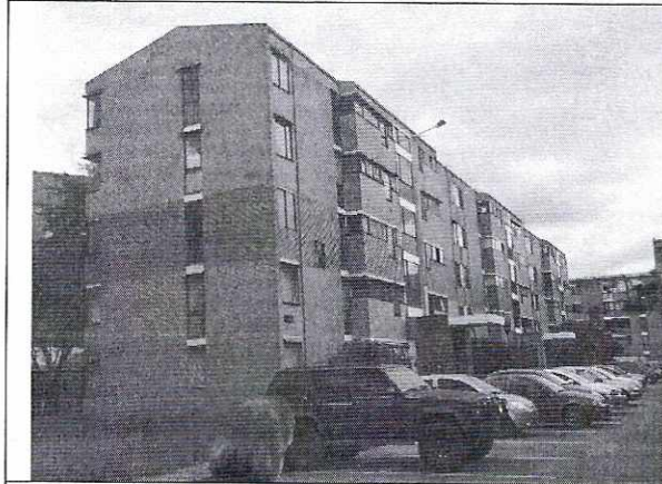
Foto 1. Fachadas costado noroccidental del predio
