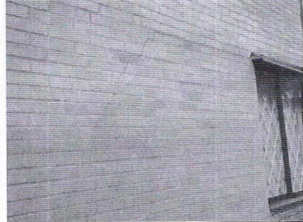
Fotos 7 y 8. Agrietamiento muros del primer piso fachada costado nororiental
