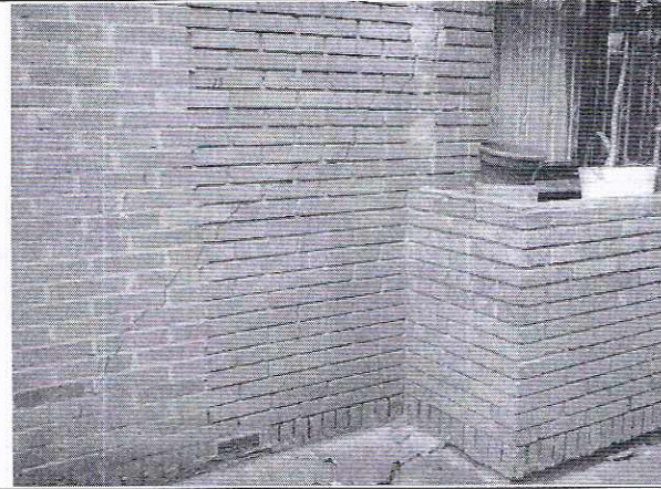
Fotos 9 y 10. Agrietamiento muros del primer piso fachada costado nororiental
