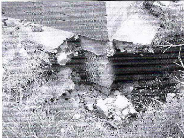
Foto 11. Excavación esquina norte del predio en la que se aprecia sobrecimiento. No se observa daños
