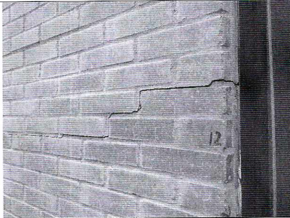
Fotos 7 y 8. Agrietamiento muros del primer piso fachada costado nororiental
