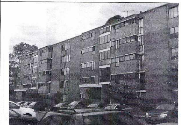
Foto 4. Fachada costado suroccidental. Acceso apartamentos
