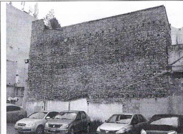
Foto 7. Vista posterior inmueble costado oriental del predio. No se observa daño en muros
