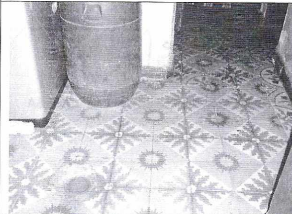
Foto 17. Vista interior tercer piso, placa de entrepiso. No se observan daños
