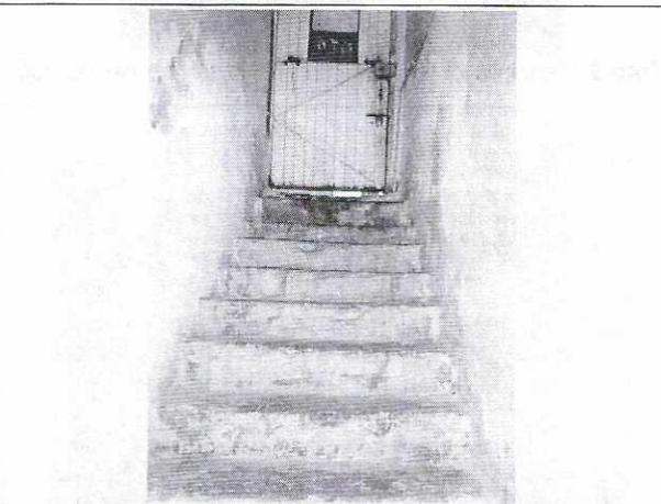
Foto 6. Escalera hall acceso. No se observan daños
