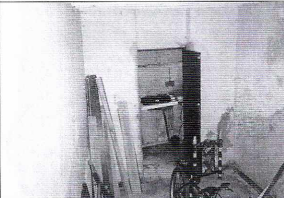
Foto 13. Vista interior primer piso. No se observan daños
