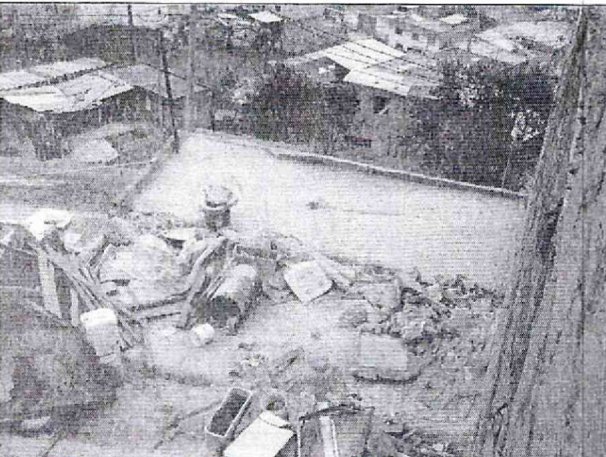
Foto 7. Vista superior sector frontal placa plana de cubierta.
