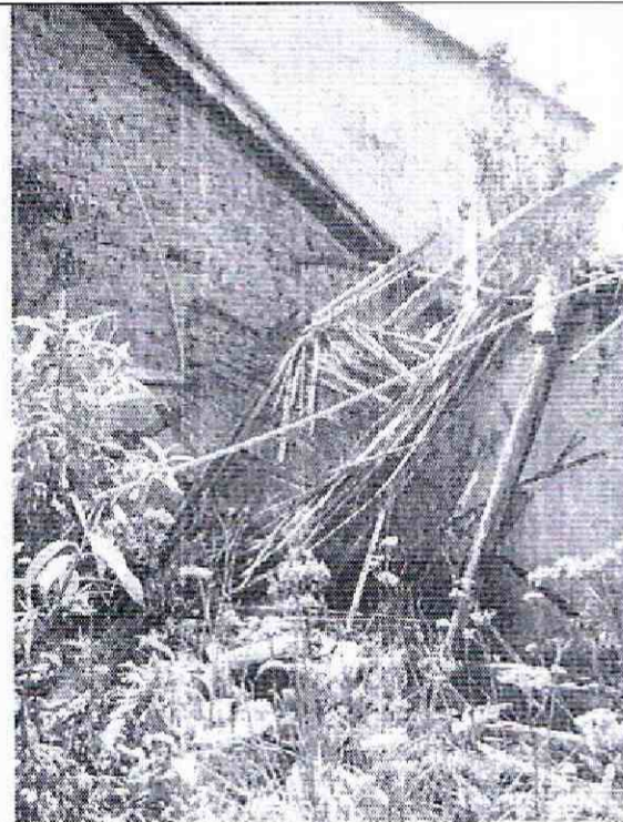
Fotos 7, 8 y 9. Sectores primer piso parte central. Pérdida del anclaje y/o uniones de los elementos de entramado de cubierta, rompimiento y caída de elementos. Colapsos de cubierta
