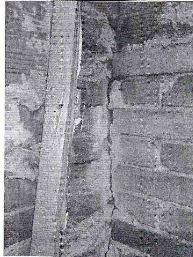
Fotos 7 y 8. Detalle intersección muro de fachada con muro interno a nivel de segundo piso. Se observa agrietamiento en mortero de pega y en unidades de mampostería.
