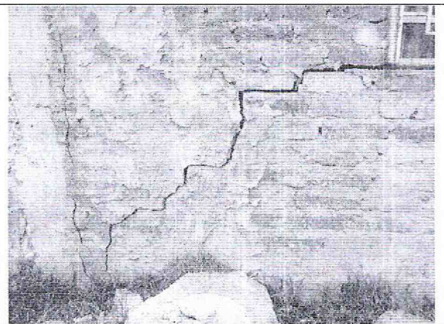
Foto 5 y 6. Costado sur oriental del predio. Agrietamiento en sentido diagonal en muro, separación unidades de mampostería, pérdida de recubrimiento y exposición de las barras de refuerzo de los elementos de confinamiento
