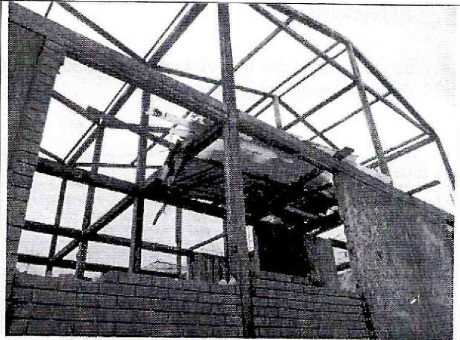
Foto 22. Elementos estructurales de cubierta expuestos.
