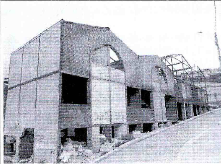
Foto 2. Fachada y muro externo de las edificaciones.
