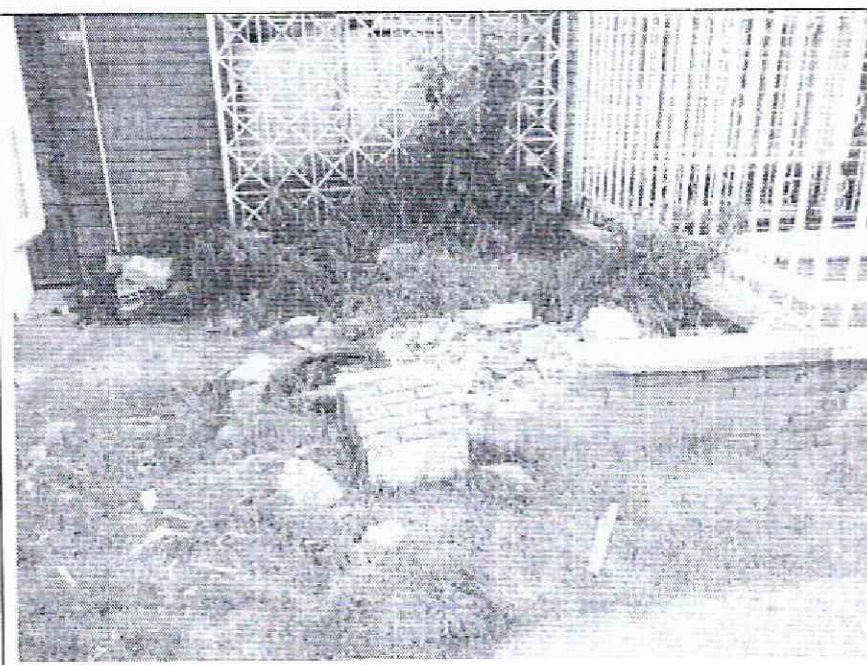
Foto 6. Mampostería del antejardín demolida.
