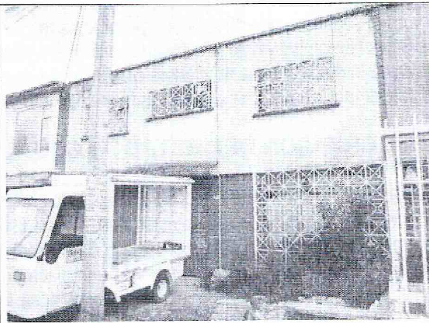
Foto 2. Muro de fachada y elementos externos.
